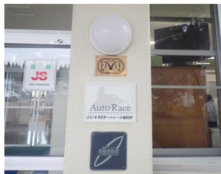
【標識(施設玄関)】
