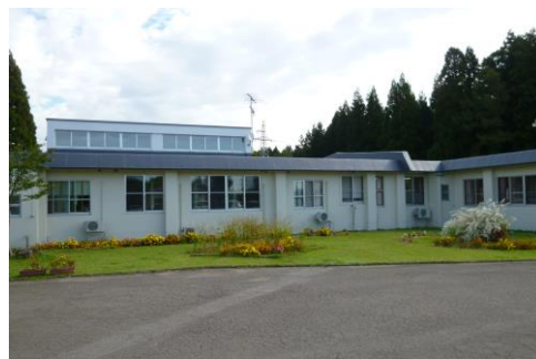
【外壁・居室西側】
