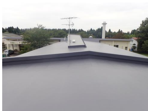
【防水・平場全景】
