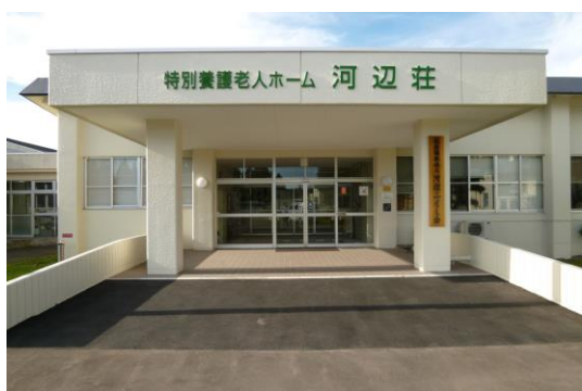
【外壁・施設正面】
