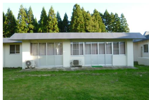
【外壁・居室北側】
