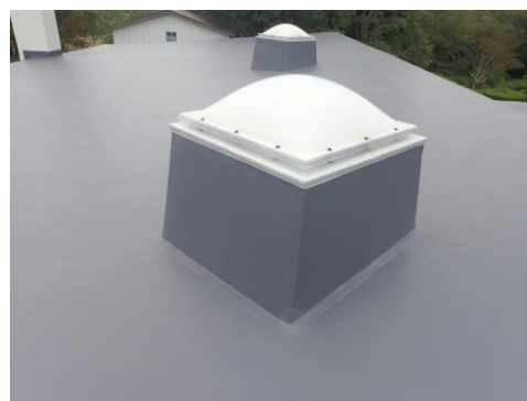
【防水・立上がり部】
