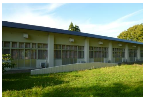
【外壁・居室南側】
